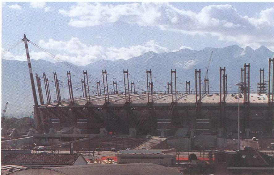
Fig. 18. Il sistema tensostrutturale di copertura adottato per il nuovo stadio di Torino a lavori ultimati.
