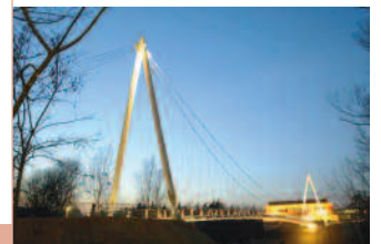
Fig. 6 - Visione complessiva della passerella.
