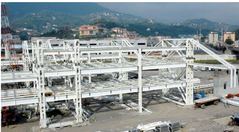
Fig. 4 Orditure delle travi degli impalcati
