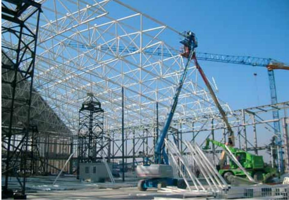
Fig. 13 - Montaggio dei moduli di reticolare
