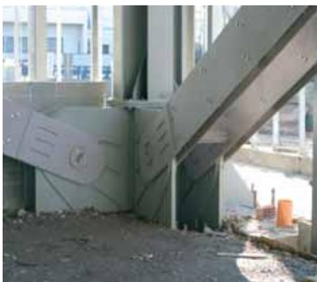
Fig. 9 - Attacco dei diagonal di controventamento
