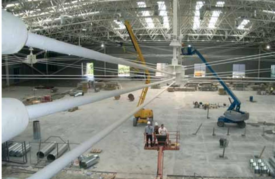
Fig. 25 - Struttura reticolare spaziale una volta rimossi gli appoggi provvisori
