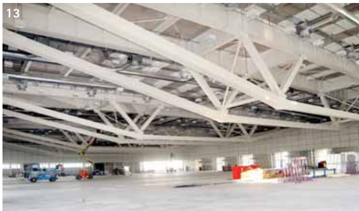
Fig. 12 - Fase di costruzione delle travi spaziali appoggiate in sommità alle torri dei vani scala in cemento armato. Fig. 13 - Travi armate spaziali di copertura con corrente inferiore in piattini S460
