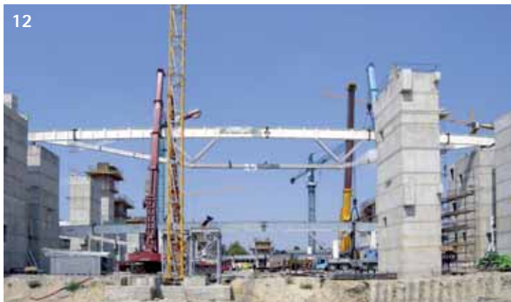
Fig. 12 - Fase di costruzione delle travi spaziali appoggiate in sommità alle torri dei vani scala in cemento armato. Fig. 13 - Travi armate spaziali di copertura con corrente inferiore in piattini S460
