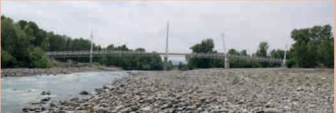
pari a 160 m, realizzato in carpenteria metallica su pile centrali in c.c.a. fondate su pali (figg. 3, 4, 5). E' infatti costituita da tre campate principali di 40 m ognuna e due di testata di 20 m; sono state previste due tipologie di plinto di fondazione:
