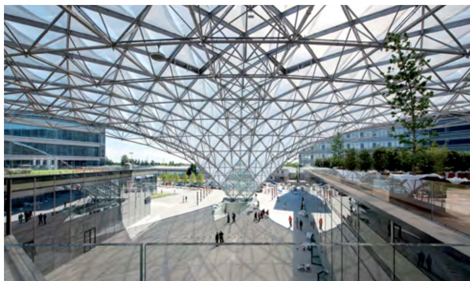
Fig. 8 - Vista dall'interno della reticolare spaziale
