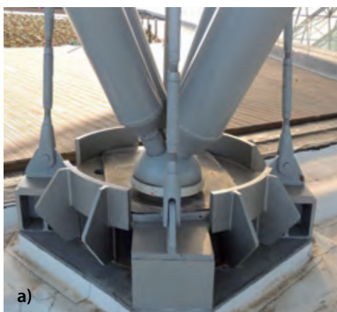
Fig. 16 - Dettaglio dell'appoggio mobile dei nodi 6 e 7: a) Apparecchio di appoggio mobile e attacco delle funi, b) Dettaglio della connessione delle funi con la sfera di intradosso della reticolare
