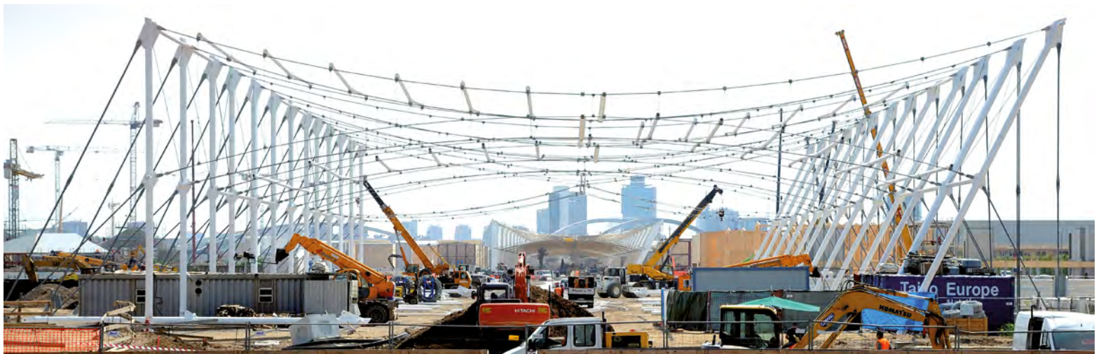
Fig. 8 - Vista delle strutture in acciaio durante il montaggio
