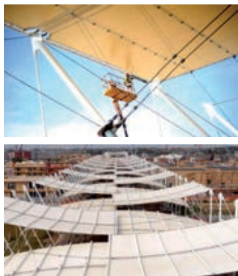
Figura 8: a) Operazioni di verniciatura della struttura in acciaio in opera, b) e c) vista aerea e da dentro i camminamenti delle strutture metalliche e della membrana di copertura del Decumano
