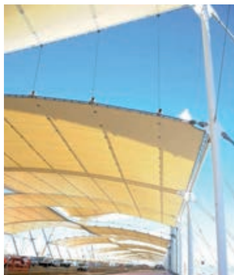
Figura 8: a) Operazioni di verniciatura della struttura in acciaio in opera, b) e c) vista aerea e da dentro i camminamenti delle strutture metalliche e della membrana di copertura del Decumano
