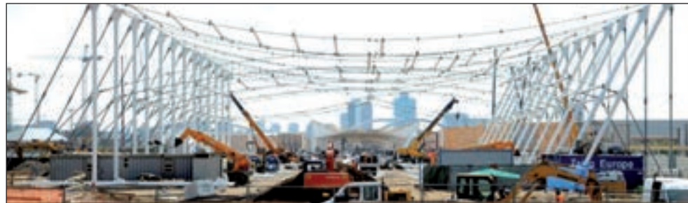
Figura 7: Vista delle strutture in acciaio durante il montaggio
