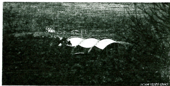
Fig. 14. Copertura di campi da tennis.
