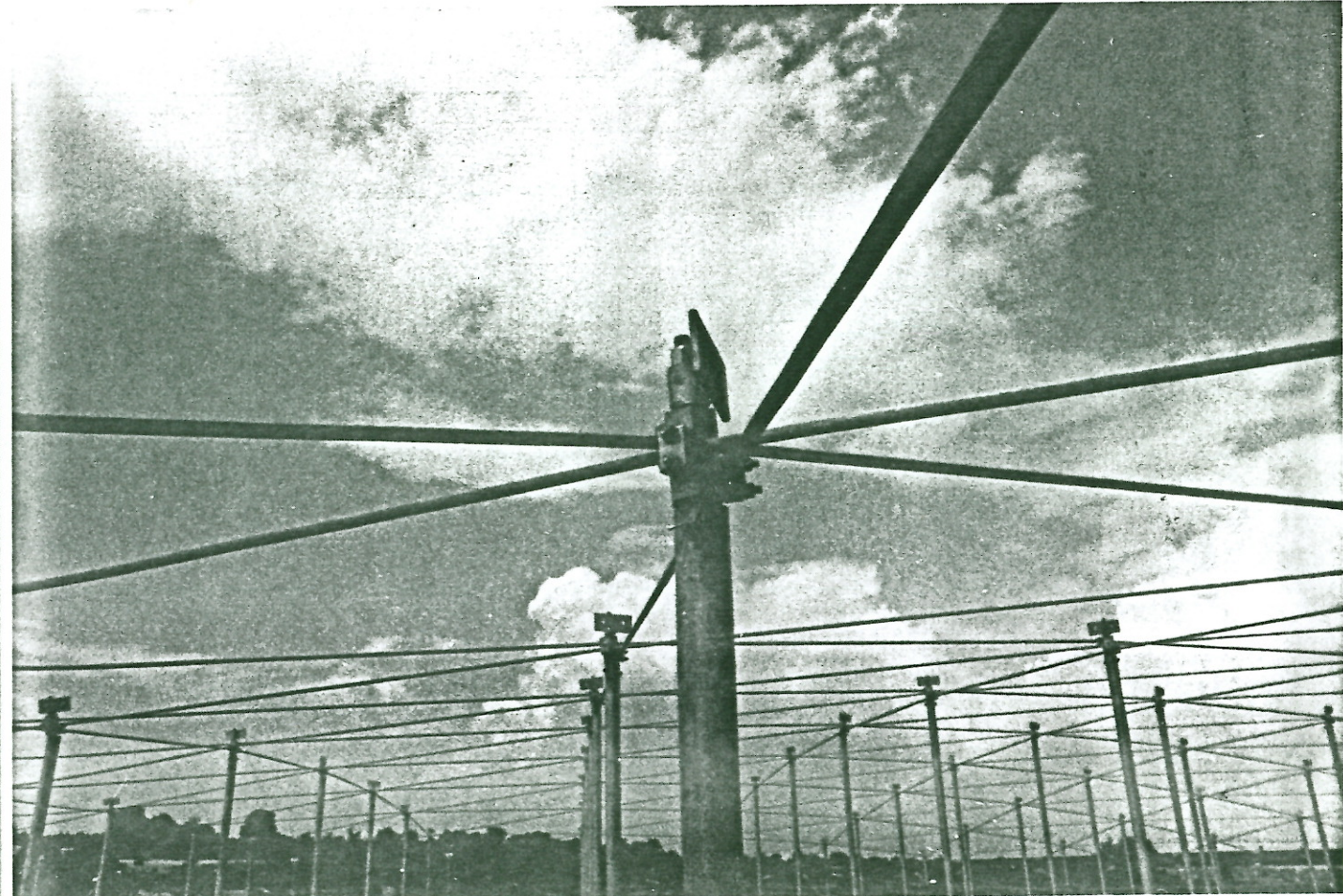
Fig. 13. Particolare di un nodo della tensostruttura.
