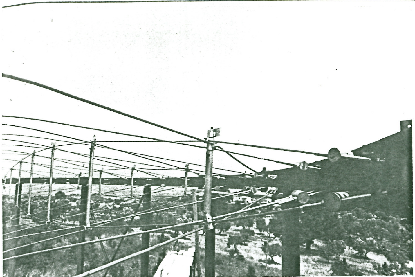
Fig. 12. Collegamento in tubo d'acciaio tra le due superfici di funi.
