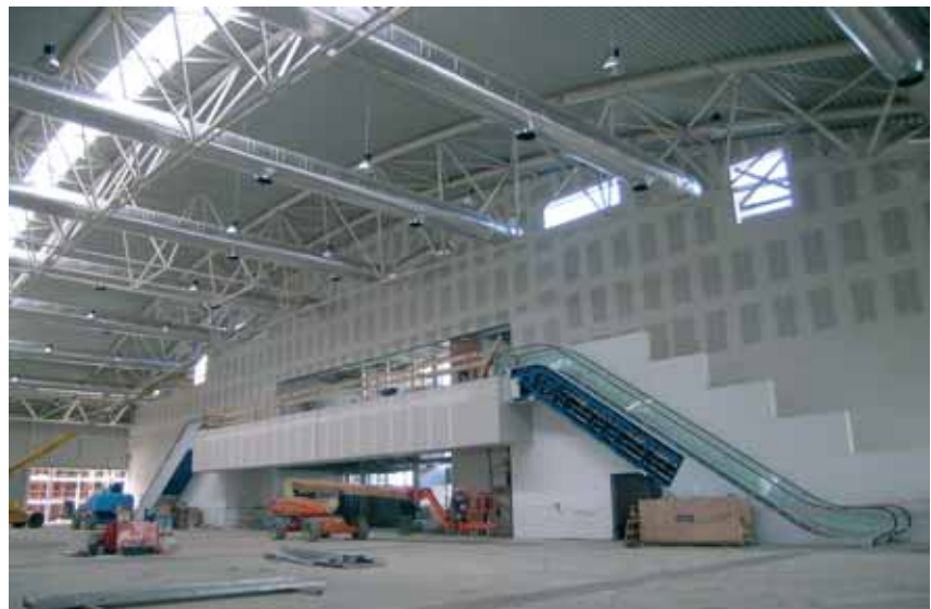
Fig. 5 - Montaggio delle strutture
