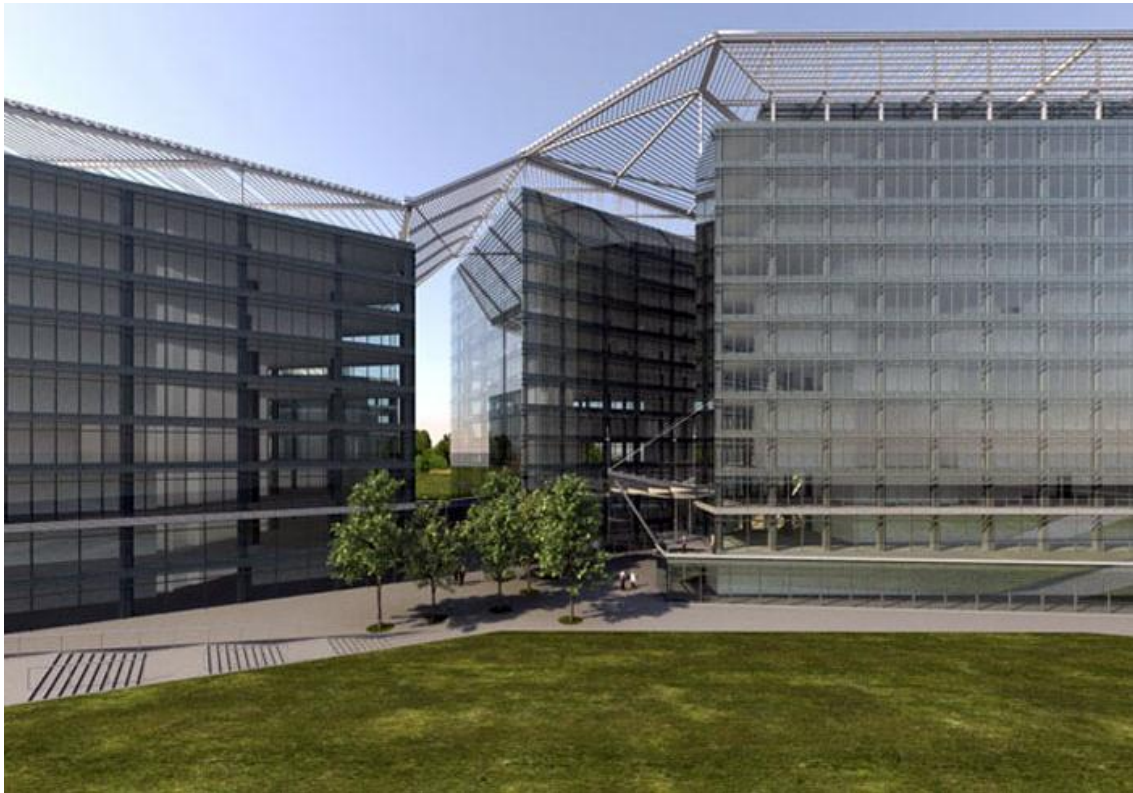
Figura 8: vista laterale degli edifici e della copertura
