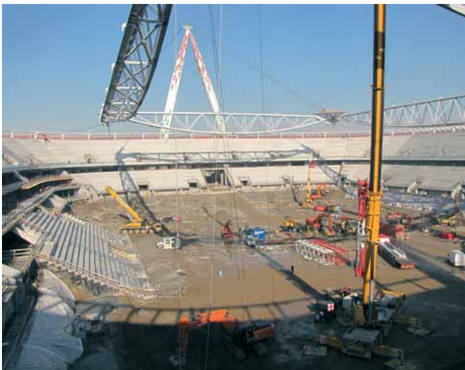
Fig. 44 - Sollevamento delle travi principali
