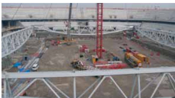
Fig. 35 - Assemblaggio delle travi principali e della torre provvisoria per il sollevamento
