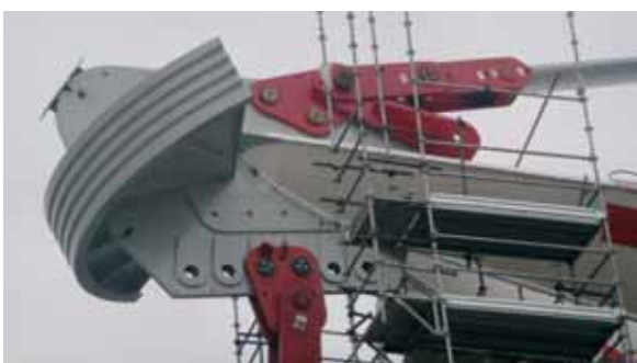
Fig. 37 - Dettaglio del nodo di sommità del pilone in cui si notano i dispositivi provvisori per il sollevamento
