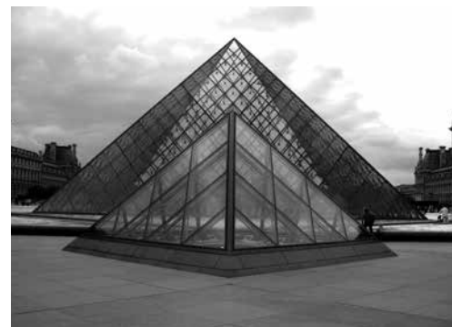
Figg.8-11 Pei Cobb Freed & Partners, Grand Louvre, Parigi, Francia, 1989. Esempio di struttura leggera in acciaio stabilizzata con cavi
