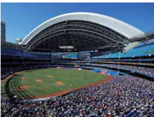
Figg.410-412 Rod Robbie, Michael Allen, Rogers Centre, Toronto, Canada, 1986-1989. La copertura in posizione chiusa e in posizione aperta
