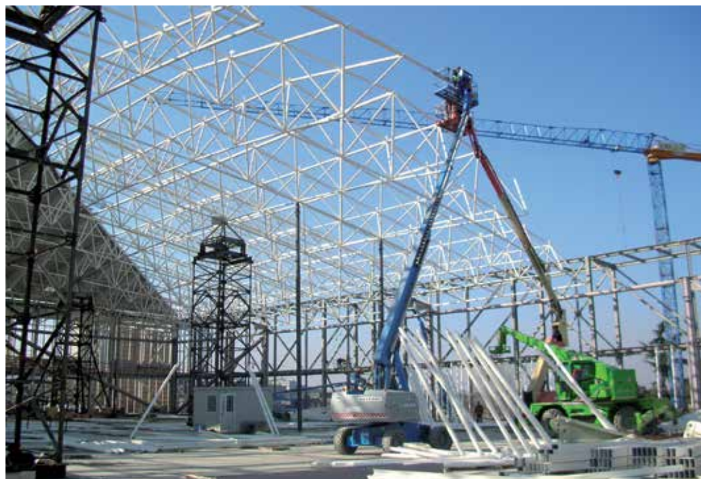
Fig. 168 Montaggio in cantiere di una struttura reticolare spaziale sorretta puntualmente da appoggi provvisori
