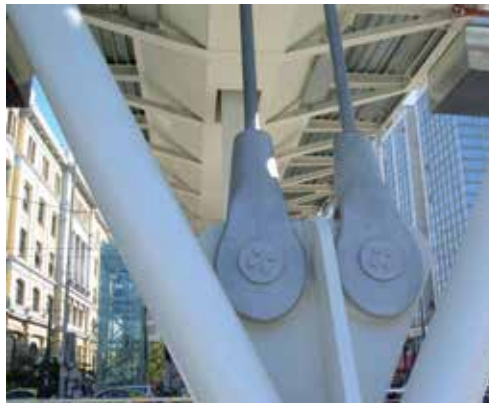
Figg.329,330 Alcuni esempi di capocorda
