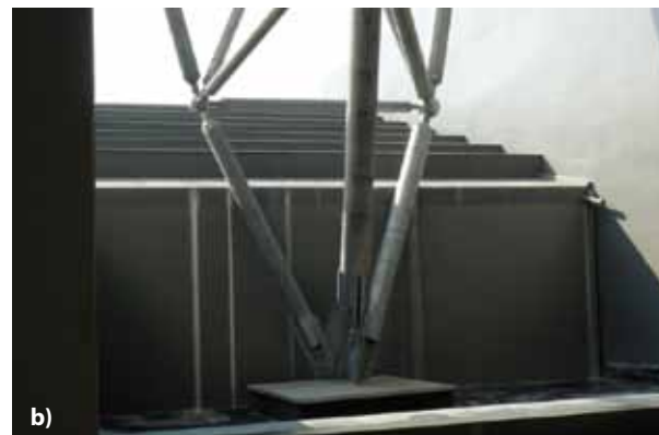
Fig. 8 - a) Appoggi della cometa sui padiglioni esistenti e b) sulla piazza antistante la sala plenaria
