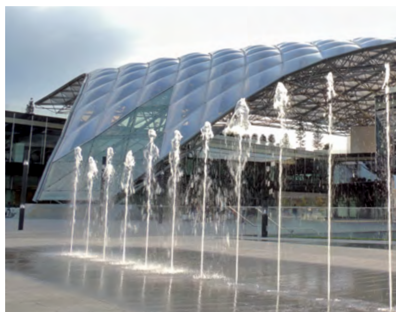
Fig. 1 - Alcune immagini della copertura detta "Vela" ai piedi della torre Unipol a Bologna
