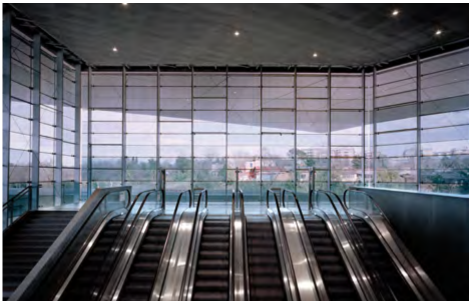
Fig. 11 - Vista interna della vetrata e della sua connessione con le strutture di copertura
