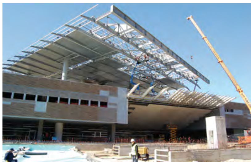
Fig. 6 - Costruzione della struttura reticolare di copertura sorretta da appoggi provvisori e posizionamento della lamiera
