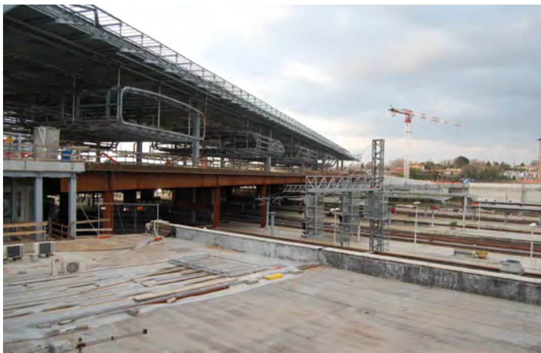
Fig. 4 - Vista della struttura del ponte inferiore durante la costruzione
