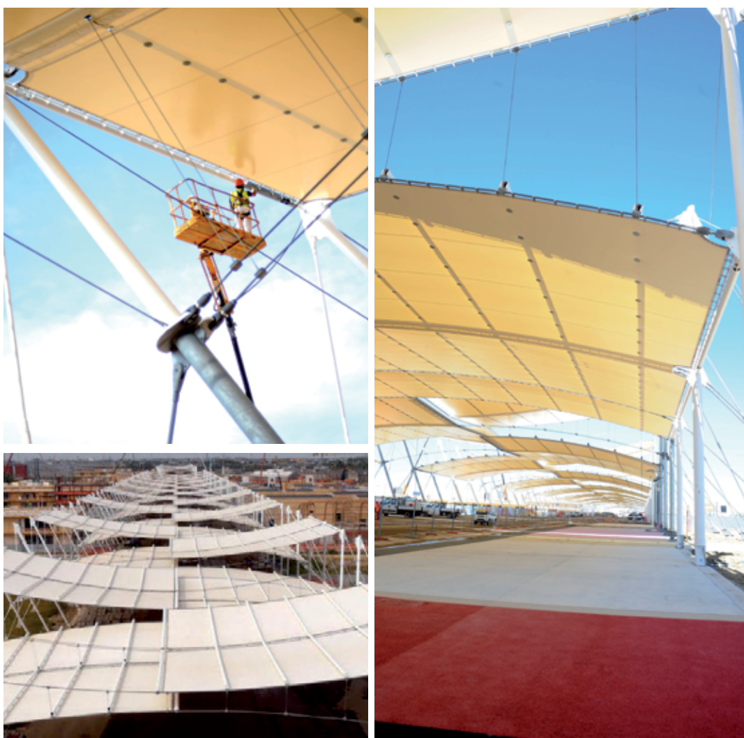
Fig. 9 - Operazioni di verniciatura della struttura in acciaio in opera, b) e c) vista aerea e da dentro i camminamenti delle strutture metalliche e della membrana di copertura del Decumano
