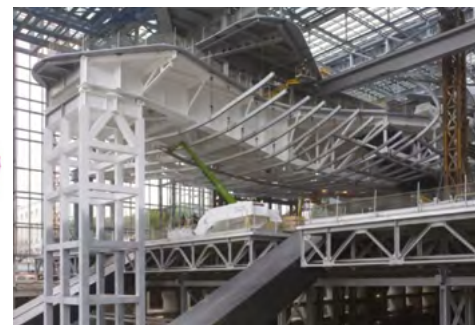
Fig. 11 - Nodo tipico di incrocio fra le reticolari dello scafo
