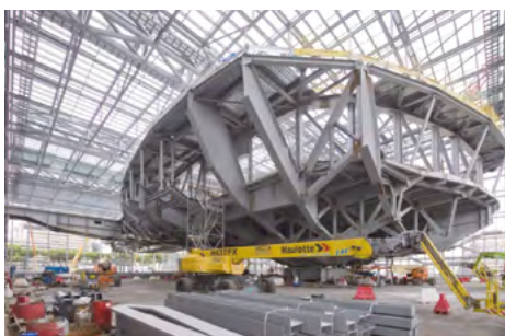
Fig. 10 - Ossatura portante dello scafo in fase di montaggio
