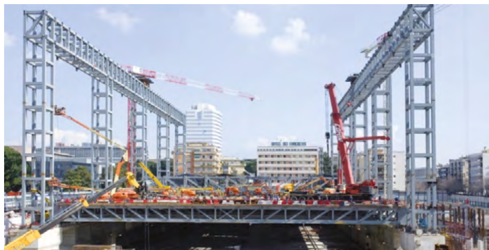
Fig. 7 - Struttura della teca durante la fase di montaggio.
