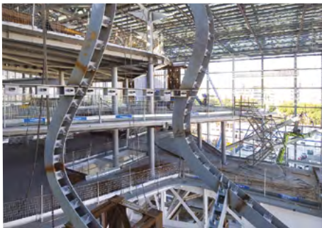
Fig. 20 - Piatti pantografati della struttura dell’involucro della Nuvola
