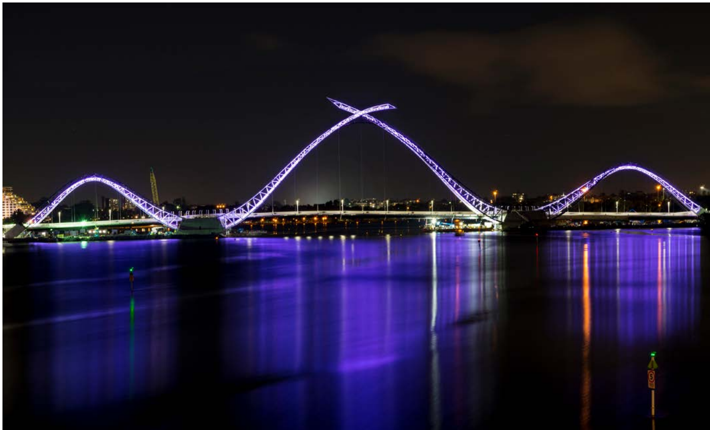
Fig. 4 – Vista della struttura completata
