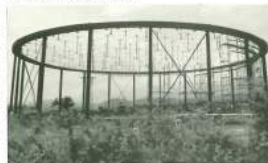
Fig. 4.5 Sistemi reticolari spaziali. a) Sistema strutturale a doppio strato con cesto centrale. b) Sistema strutturale con distribuzione radiale di travi di funi senza cesto centrale.
