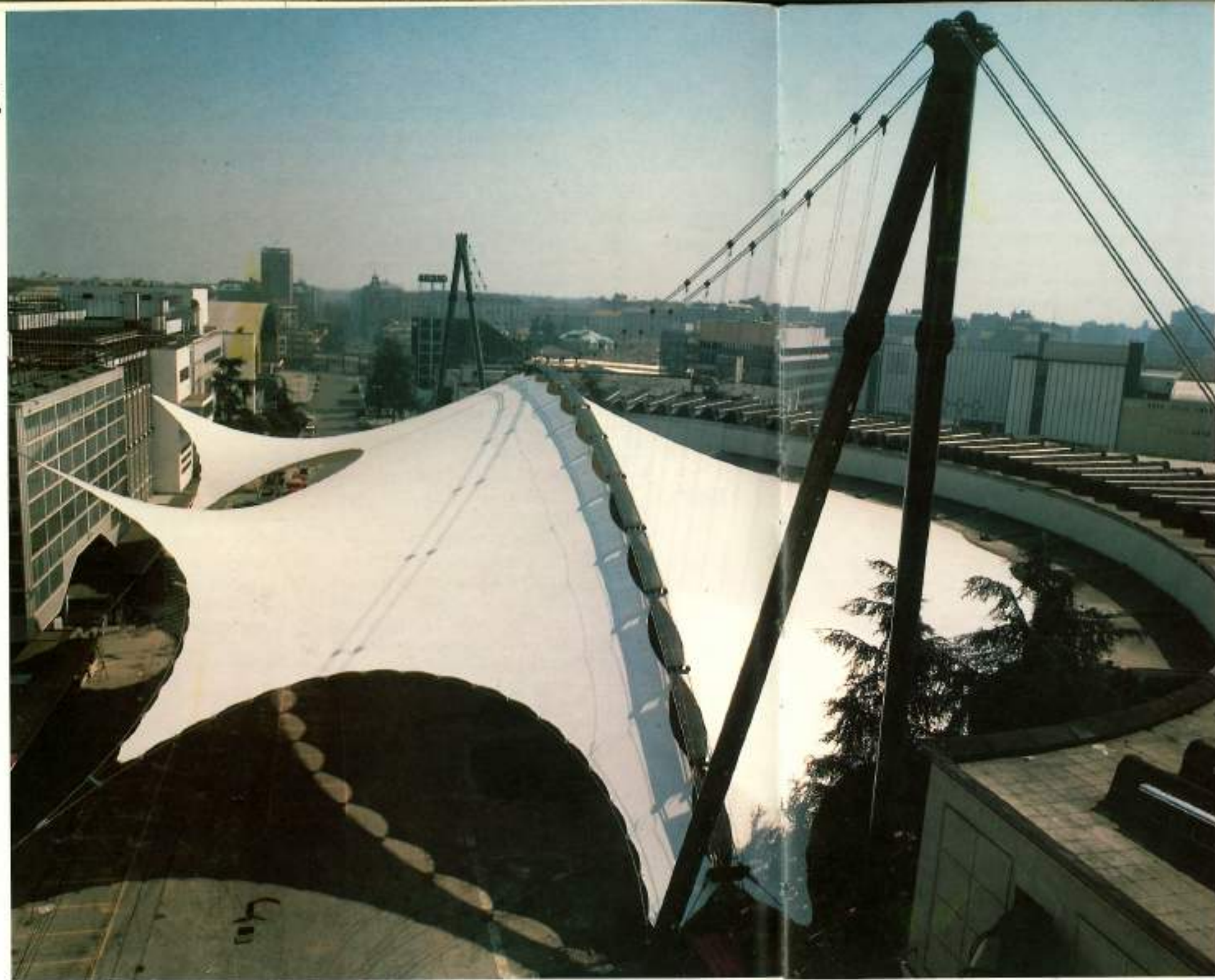
Fig. 8.11 Tensostruttura per la Fiera di Milano.
