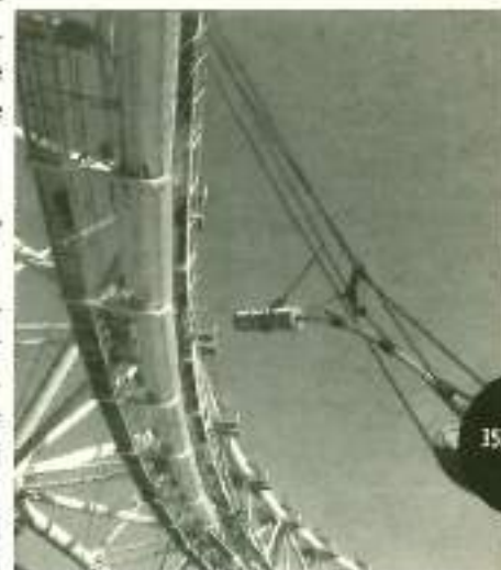
Fig. 8.16 Argano di sollevamento della fune portante: fase 5
