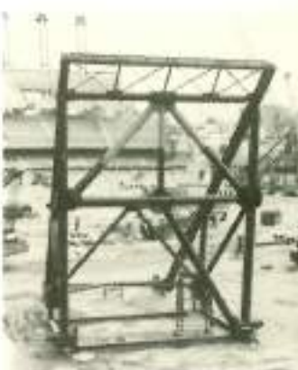
Fig. 8.50 Modello spaziale in profili tubolari di acciaio della tribuna a quota +18 m.
