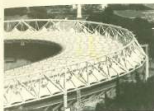
Fig. 8.99 Vista parziale della copertura
