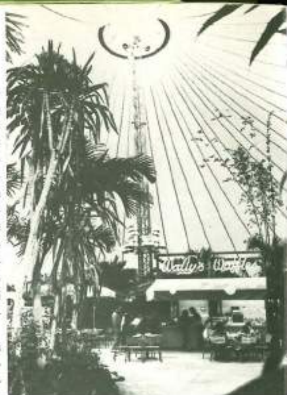
Fig. 4.4 Sistema di copertura realizzato con tessuto in fibra di vetro ricoperto con Teflon [4.9].
