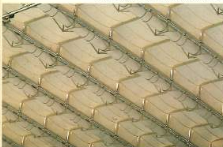
Fig. 8.55 Dettaglio della copertura dall'interno
