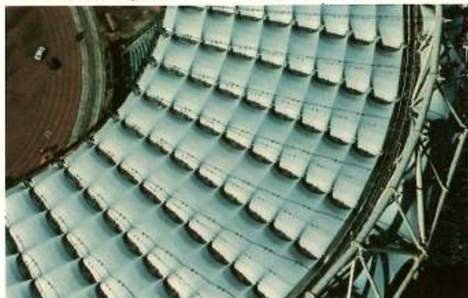
Fig. 8.61 Vista aerea di una zona della copertura dello Stadio Olimpico dove si possono notare i vari elementi costitutivi del sistema costruttivo: l'anello esterno reticolare, le tensostrutture radiali, l'anello interno in funi ed i moduli di copertura in Teflon.
