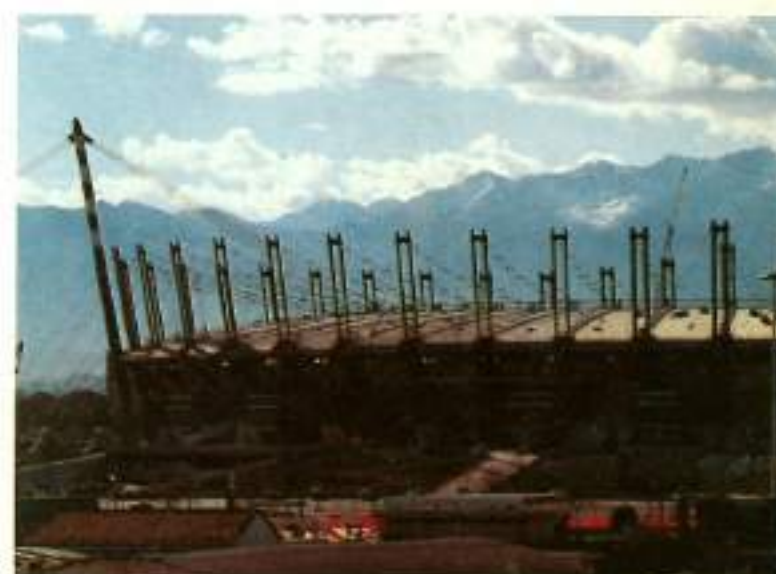
Fig. 8.57 Il sistema tensori strutturale di copertura adottato per il nuovo stadio di Torino a lavori ultimati.
