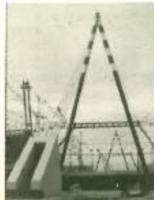
Fig. 8.29 Cavalletto d'ancoraggio longitudinale.
