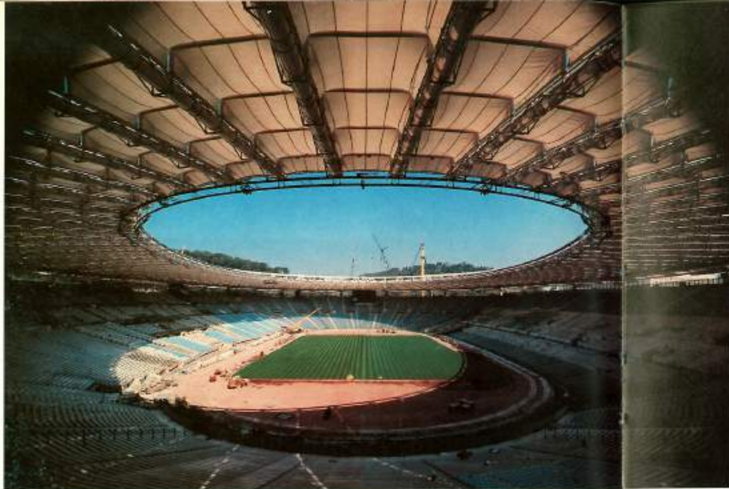
Fig. 8.54 Vista interna dello Stadio Olimpico, Roma.
