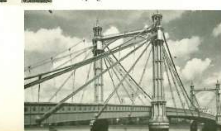
Fig. 1.15 Albert Bridge, sul Tamigi (Inghilterra 1873).
