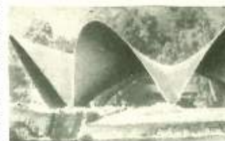
Fig. 1.3 Volta sottile in c.a. nel parco ristorante di Xochimilco (Messico) realizzato da Felix Candela (1.1)
