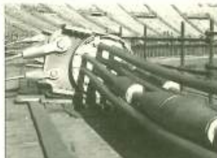
Fig. 8.89 Particolare del morsetto ad attrito che unisce le funi portanti ed il sistema di funi radiali. Si notano anche le unioni tra le due funi dell'anello interno e i carter di posizionamento degli estensimetri di controllo.
