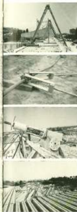
Fig. 7.30 Alcune fasi di montaggio: messa in opera dei cavalletti (a) e montaggio sul terreno delle travi di funi (b); tesatura (c) e messa in opera della copertura (d).
