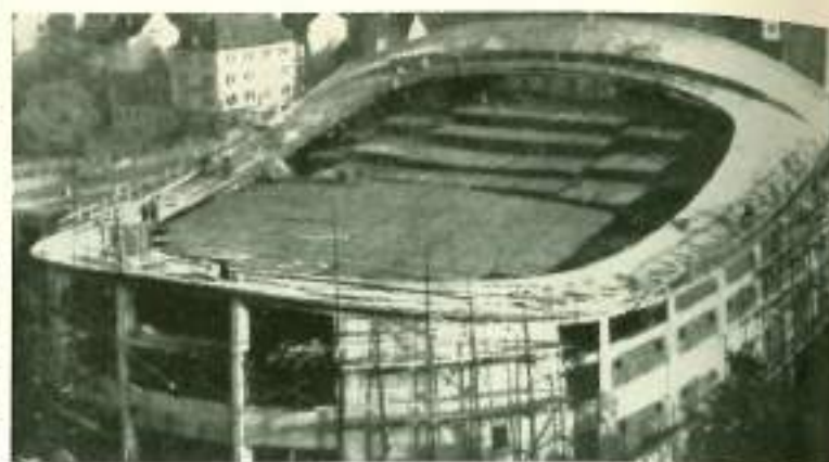
la piscina in fase di costruzione
