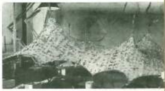
Fig. 3.6 Modello in fili d'acciaio del padiglione della Germania Federale all'Expo 1967 di Montreal [3.3].
